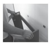
TIGHTEN THE BRACKETS ON THE UNIT SO THAT THE FUR-NITURE FITS TO THE WALL AND ADJUST THE LEVELS
